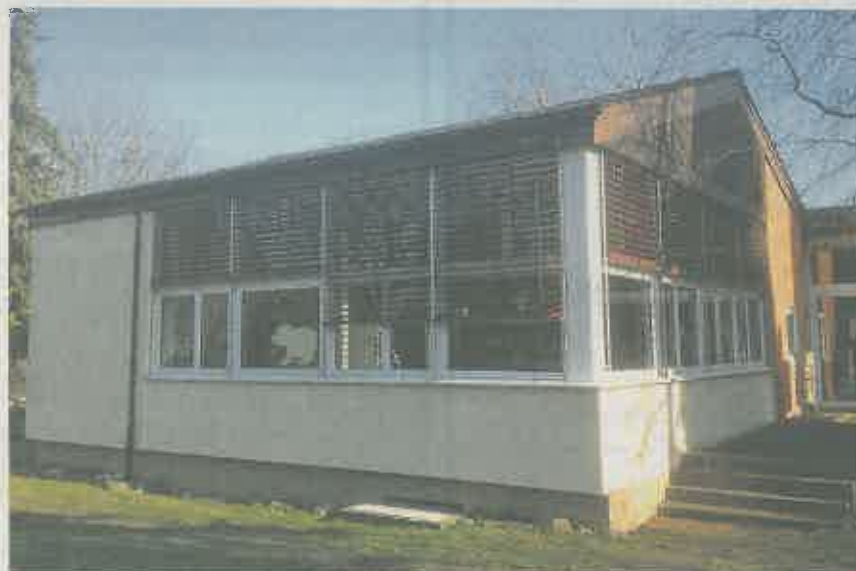
Die Tagesstätte für Betagte zieht nach dem Umbau in den ehemaligen Kindergarten im Nebengebäude.
