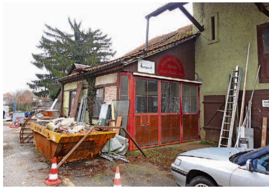
Gesuch für Teilabbruch des ehemaligen Garagen- und Lagerteils an der Schaffhauserstrasse 12 in Stein liegt bis zum 6. März öffentlich auf. (CHR)
