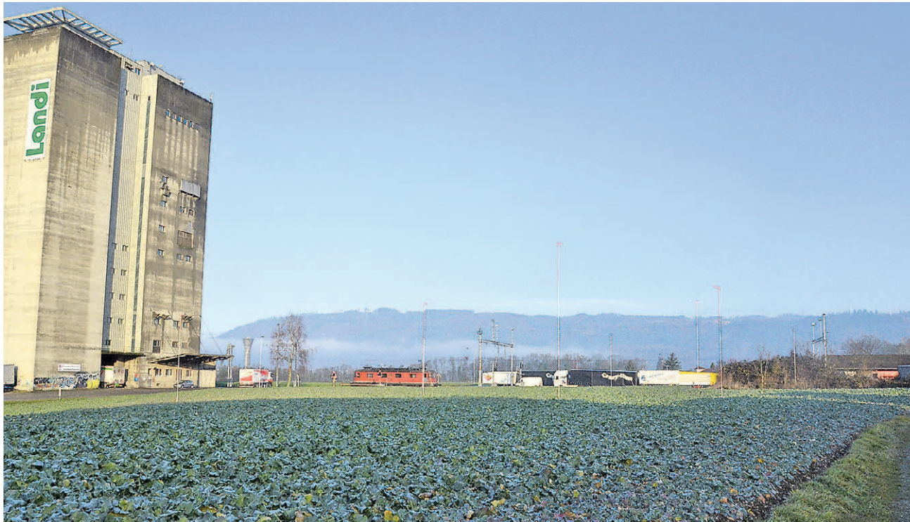
Die Bauprofile stehen: In Eiken will die Firma Densa das neue Betriebsgebäude erstellen.
