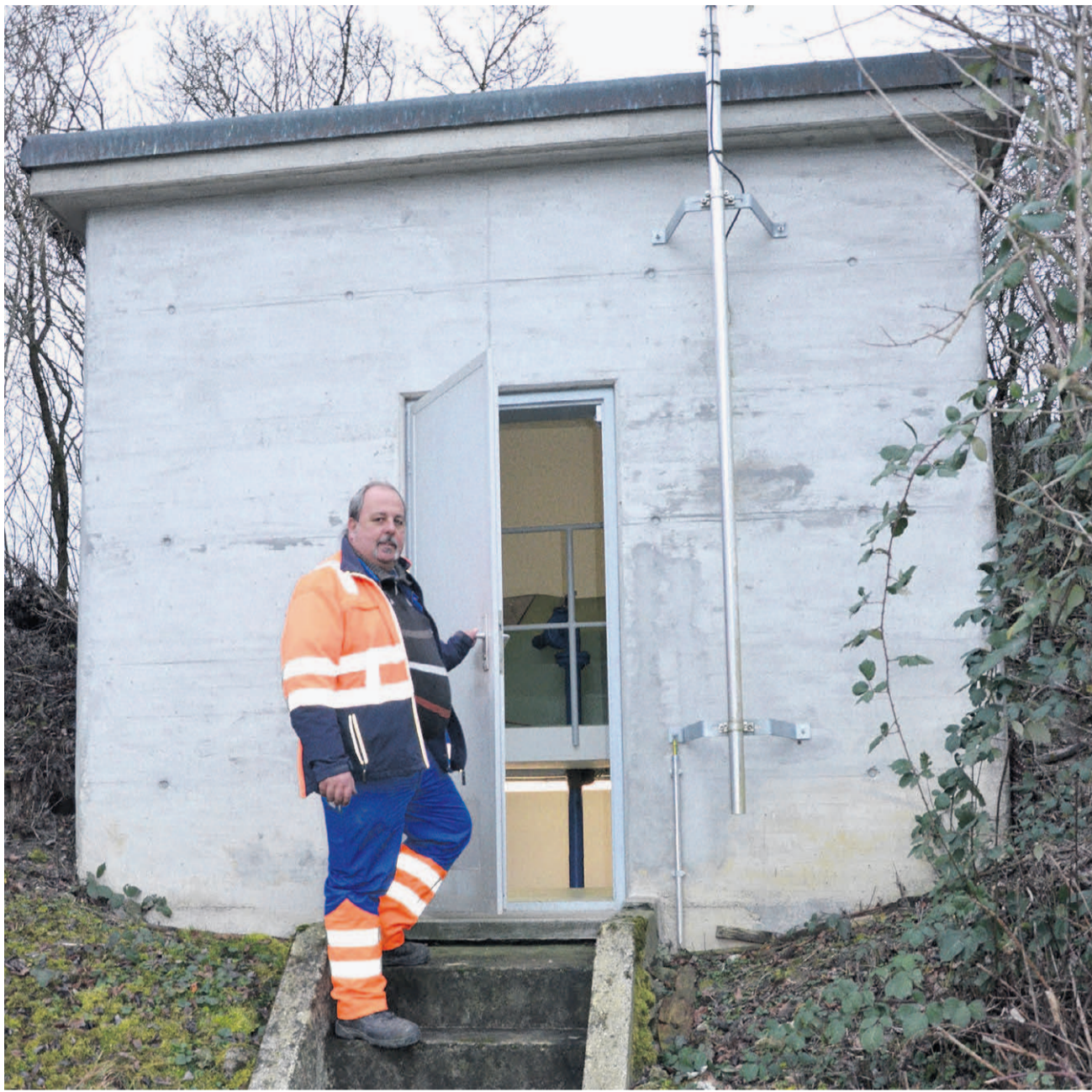
Das Wasserreservoir «Brochs» auf dem Sulzerberg wird zurückgebaut. Brunnenmeister Kurt Obrist freut sich, dass dort ein neues mit mehr Fassungsvermögen erstellt werden kann.
