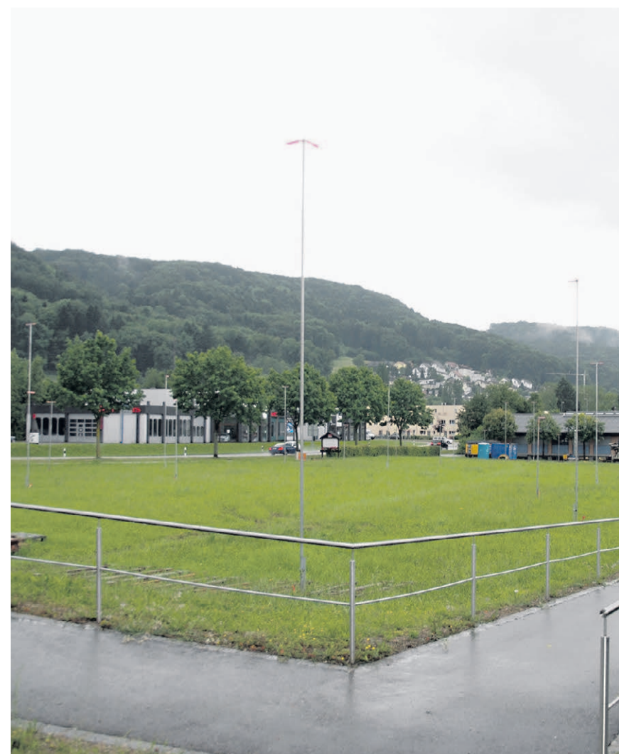
Die Bauprofile sind gestellt.
