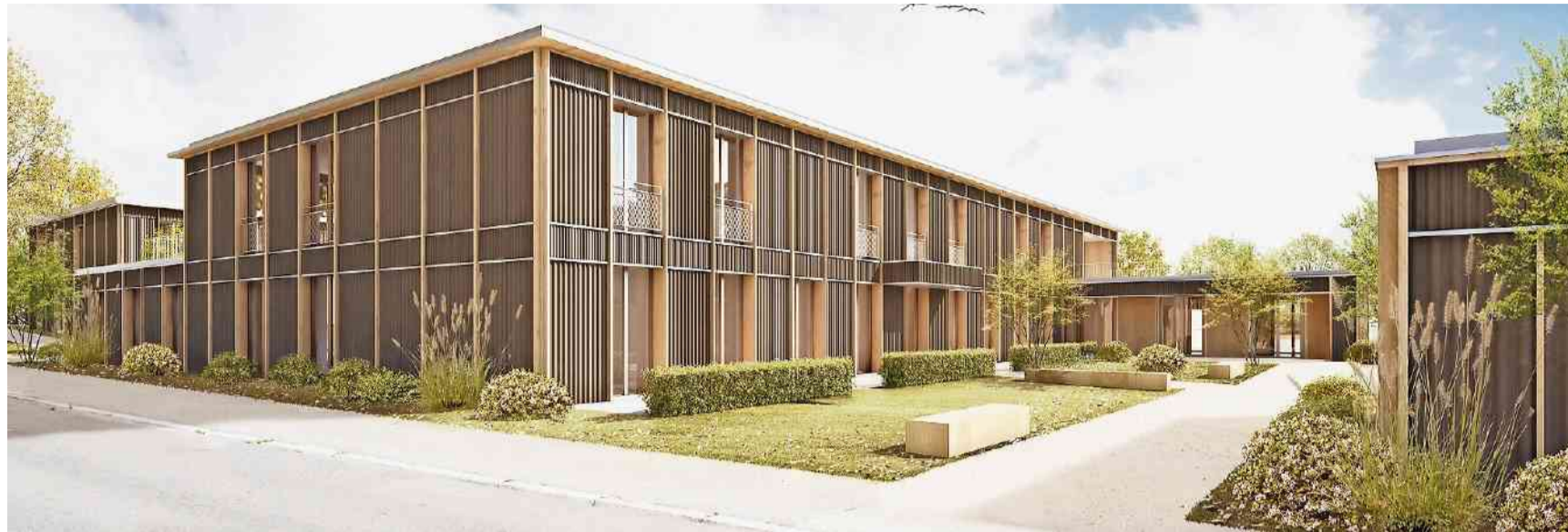
Für die Architekten ist der Bau der neuen Wohn- und Ateliergebäude in Stein «herausfordernd und reizvoll zugleich».
